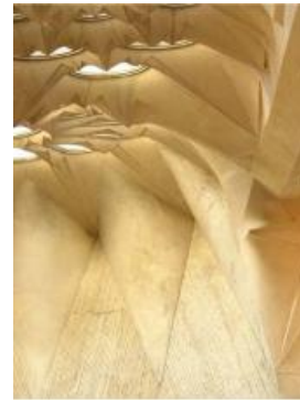
Abbildung 6: hyperbolische Paraboloid in der Sagrada Familia (vgl. Scienceblogs)
